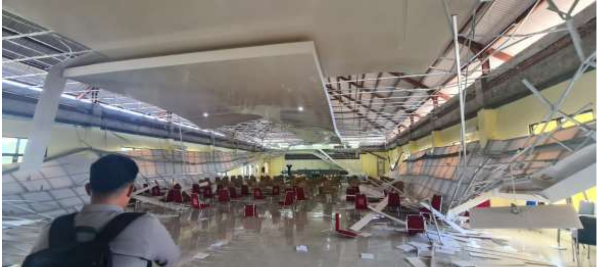
Gambar 7. Gedung Kantor Ortala Prop. Sulawesi Barat di Mamuju
